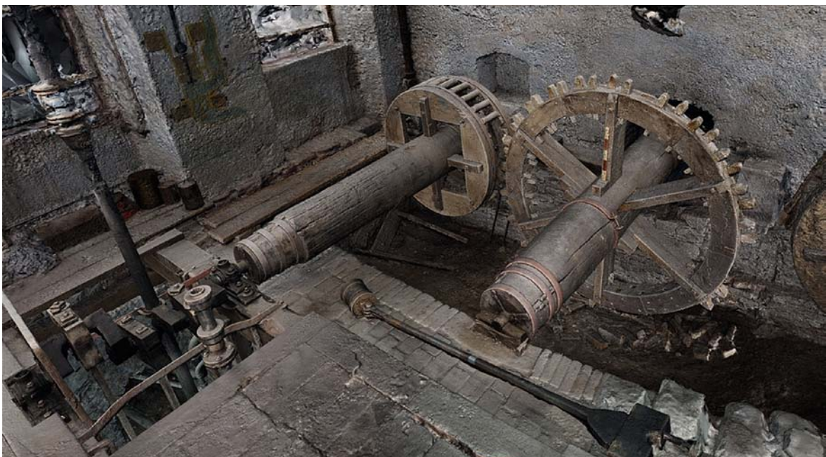
Abb. 4: SfM-Modell mit farbiger Fototextur (Ausschnitt): Pumpenraum, Unteres Wasserwerk (1762–1765), Schlossgarten Schwetzingen. Erstellt mit der Software RealityCapture, 2017. Bild: Markus Steffen © LAD RPS
